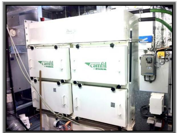
Figure 12 : Caissons de filtration à charbons actifs sur un réseau de ventilation, avant rejet à la cheminée
