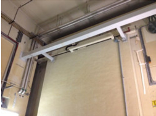
Figuur 3.1: Aangebrachte steun aan geschilderde deur lokaal 0.034
