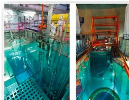
À la centrale nucléaire de Tihange, les assemblages sont ensuite transférés vers le bâtiment DE, un autre bâtiment d'entreposage de concept «humide». C'est dans ce bâtiment qu'ils seront conditionnés en emballages pour être transportés vers la nouvelle installation d'entreposage.
